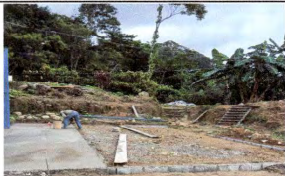
Foto 3: Sustitución de piso de tierra por piso de torta de concreto (modulo 1 y pasillo)
