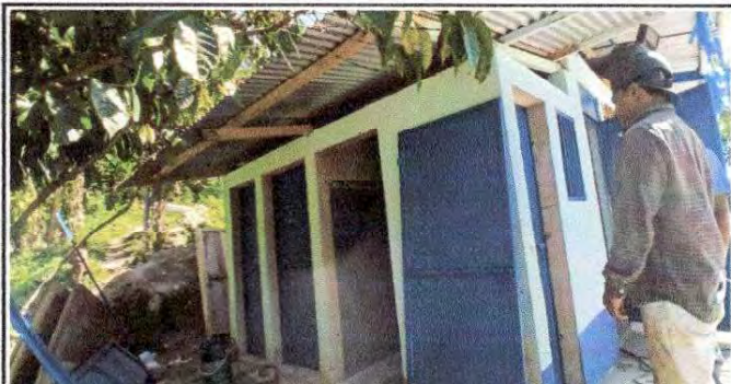
Foto 7: Fabricación e instalación de puertas de metal en baños
