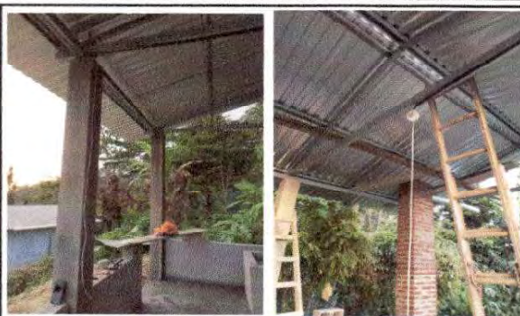
Foto 8: Reparación de sistema eléctrico
