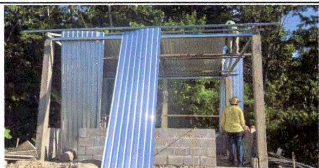
Foto1: Sustitución de lámina, por lámina troquelada aluzic calibre 26 (Cocina)
