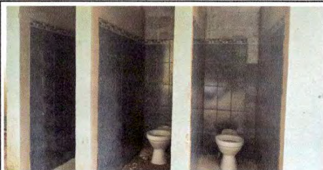
Foto 5: Sustitución de piso de torta de concreto por piso cerámico (baños)
