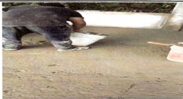
Foto 4: Sustitución de piso de tierra por piso de cemento líquido (cocina)
