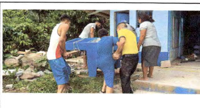
13: Sustitución de pila de cemento dos labaderos
