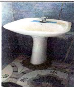
Foto 9: Sustitución de lavamanos
