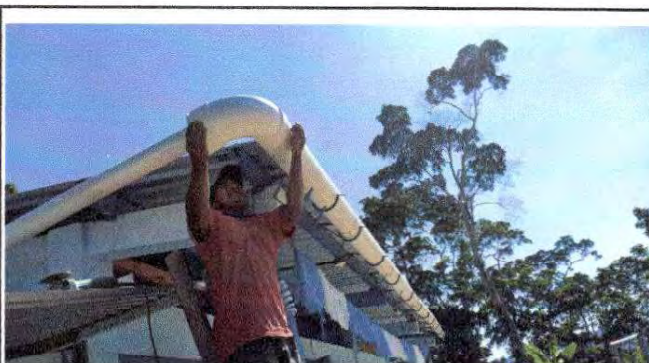
Foto 10: Reparación de bajada de agua pluvial PVC 3 y sustitución de soporte o pescante de metal
