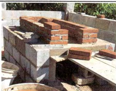
Foto 12: Sustitución de estufa rural (Completa, incluye chimenea y plancha de metal)
